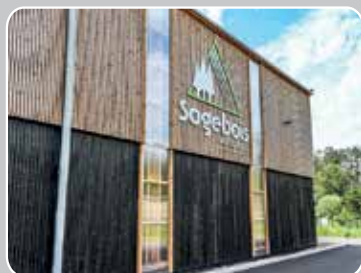
Plateforme de thermochauffage Xertigny Finalisation des travaux et installation d'un four de thermochauffage permettant de traiter localement le hêtre.
