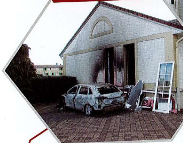
Funérarium avant travaux
