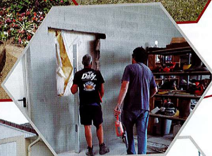
Pose fenêtre services techniques
