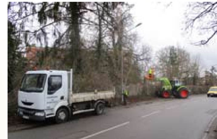
L'élégage et la sécurisation rue du Général de Gaulle (le long du Musée Militaire) avec les services techniques de la Commune de Portieux
