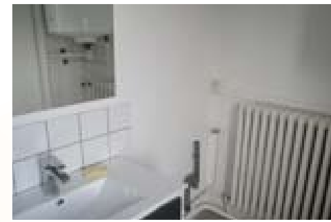
La réhabilitation d'un logement au 23 rue du Pincieux
